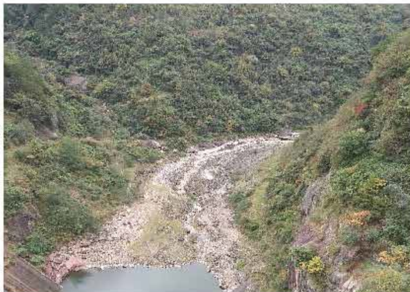
坝下河道现状
