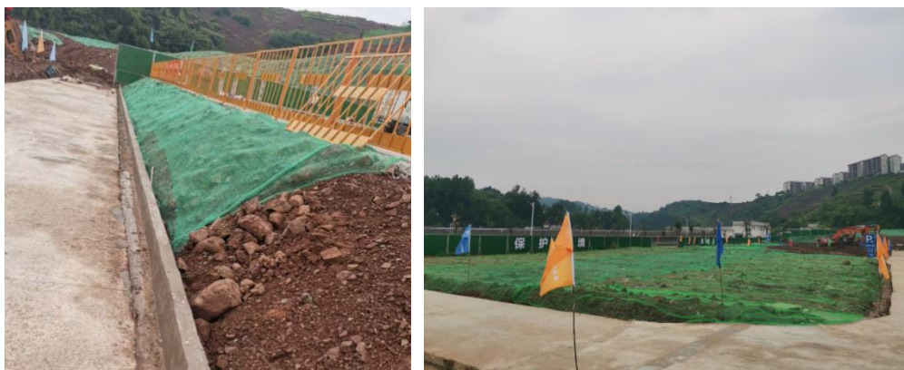
图 4.5-2 规划功能区在建地块水土保持措施现场照片
