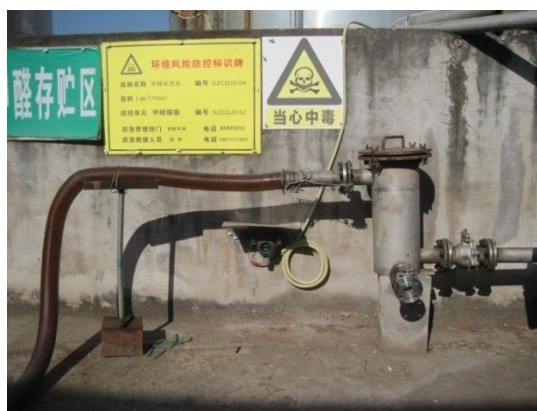
围堰为报警装置及管道切断阀
