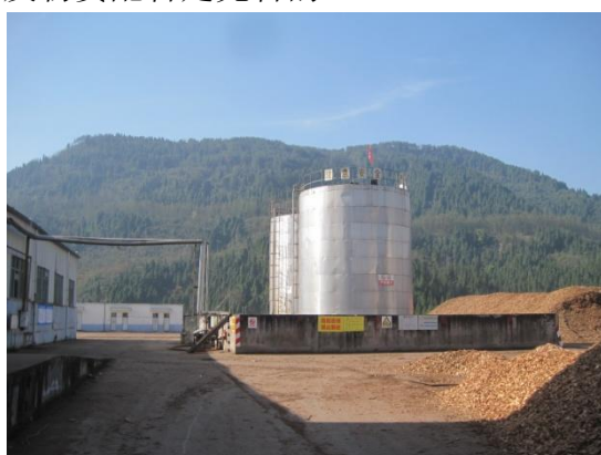
甲醛储罐区围堰
