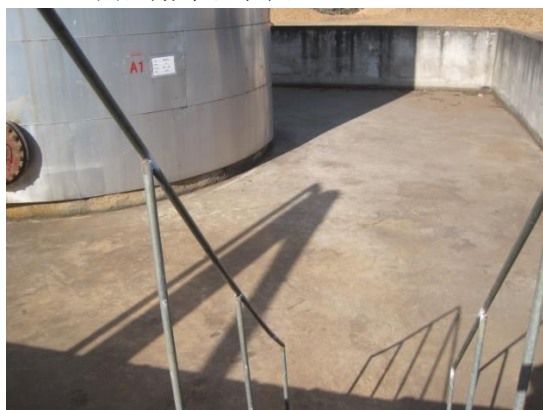
储罐围堰内防渗地面
