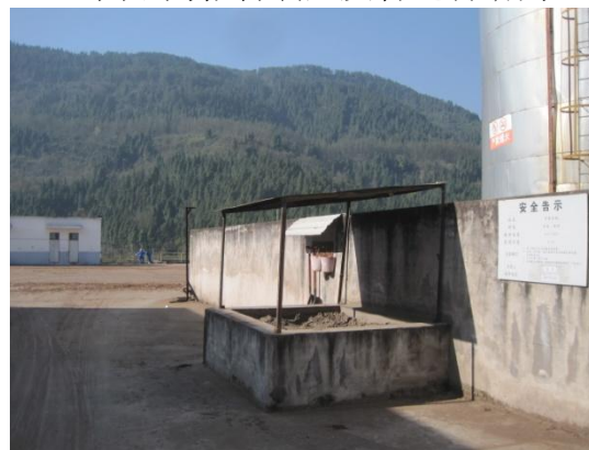
储罐围堰外消防沙
